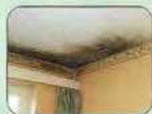
→ augmenter la température de la paroi en augmentant la température ambiante du local, en isolant la paroi et en supprimant les ponts thermiques ;
