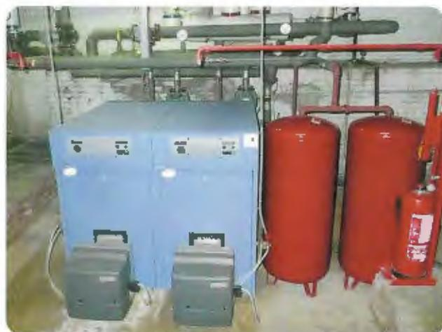
De cette façon, il est possible d'adapter la puissance fournie aux besoins de chauffage. Les différentes chaudières et/ou les allures de brûleur sont allumées ou éteintes en fonction de la demande de chauffage.
